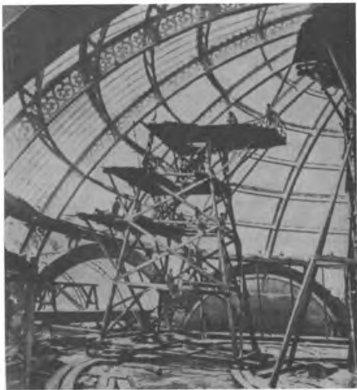
Центральный купол галереи Виктора-Эммануила II (в процессе строительства). Милан, 1865—1867 гг.
