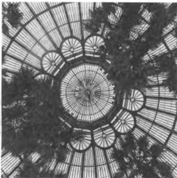
Вид конструкции крыши.
