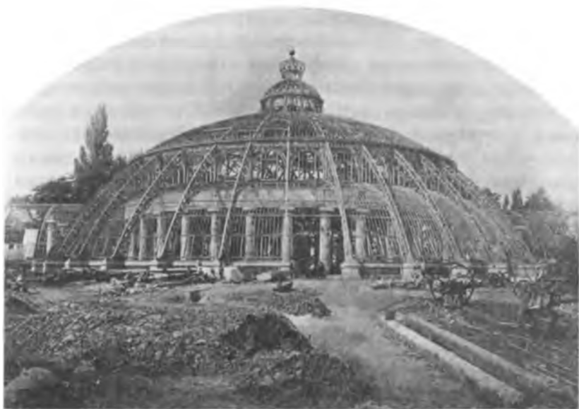
Теплица в парке замка Лекен (юг Брюсселем) во время строительства. 1875 г.
