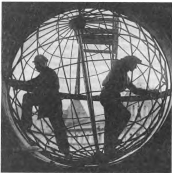
Аркадий Шайхет. Монтаж глобуса на здании московского телеграфа. 1928 г.
