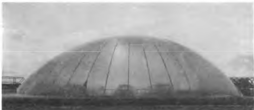
Аксель Таллемер. Airquarium . Для Festo Corporate Design, 2000 г. Диаметр 32 м, высота 8 м. Стабилизируется с помощью вращающейся балластной цистерны.
